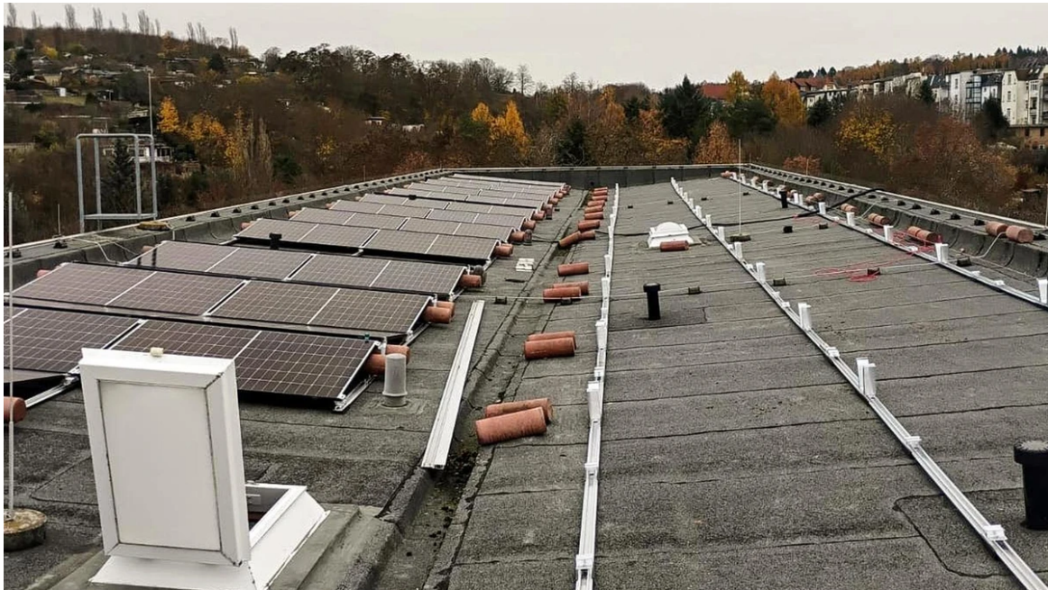
Montage der Photovoltaikanlage in der Pskower Straße im November 2025 © Funkemedien Thüringen | WBG Glück Auf
