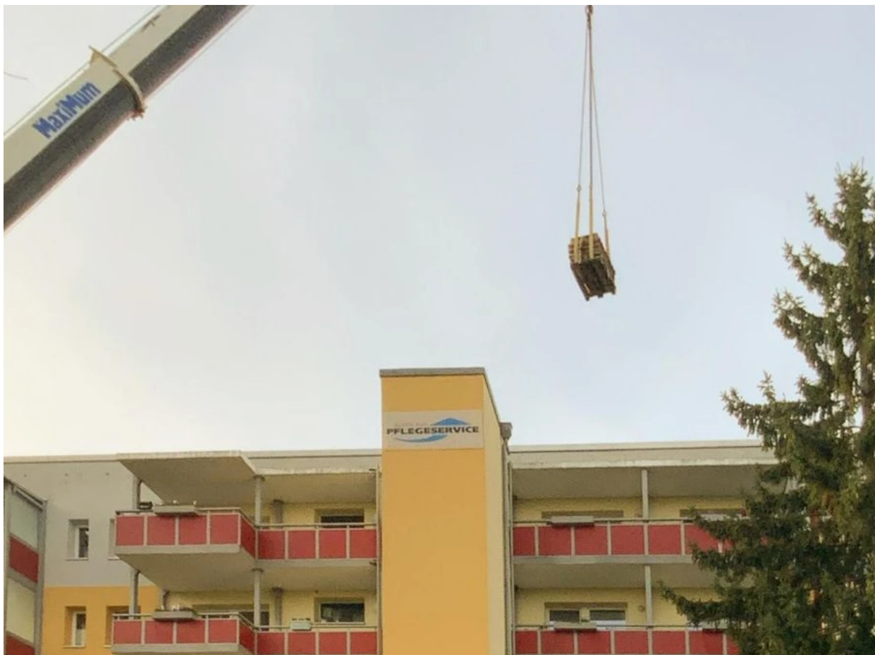
Montage der Photovoltaikanlage in der Pskower Straße im November 2025
