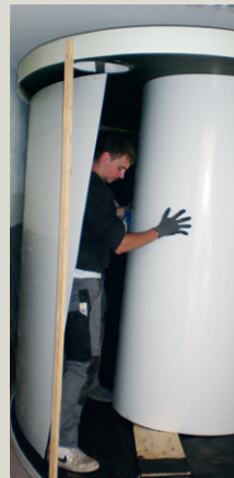
Deckel abstützen • Mantel aufrollen • alle Teile verschrauben • vernieten • abdichten • Armaturen anbringen ... FERTIG!
