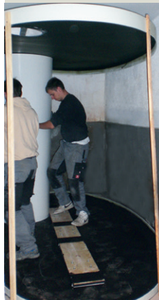
Deckel abstützen • Mantel aufrollen • alle Teile verschrauben • vernieten • abdichten • Armaturen anbringen ... FERTIG!
